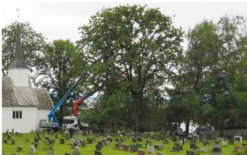
Lift og kran i sving før trefellinga.
