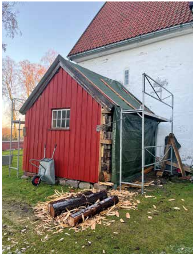
Taket på sakristiet på Hustad er lektet opp og klart for legging av takstein igjen. Foto: Privat.
